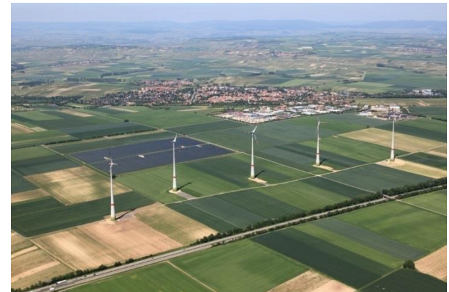
Solarfeld und WEA in Wörrstadt
