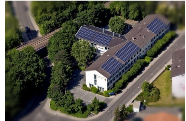
Photovoltaikanlage auf dem Dach des VG-Gebäudes
