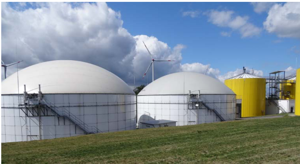
Quelle: Energieagentur Rheinland-Pfalz
