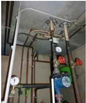
Ungedämmte Leitungen Ungeregelte Pumpe
