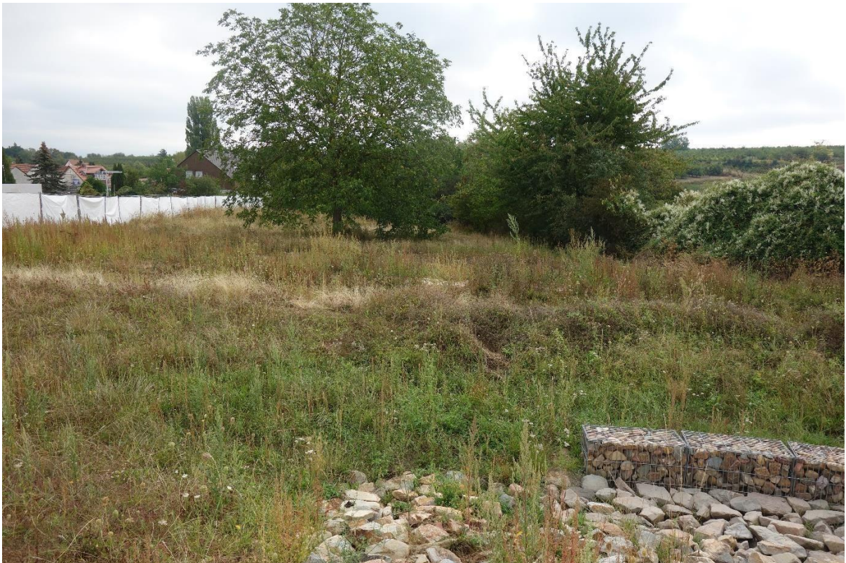
Einlaufbereich Mulde 1 und Überlauf in die Mulde 2
