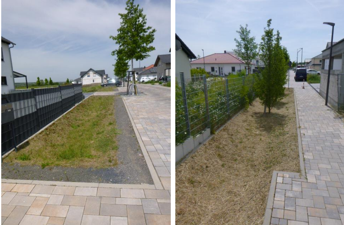
Abbildungen: Maßnahme im Mai 2022 [Bildrechte: M. Körner (SGD Süd)]
