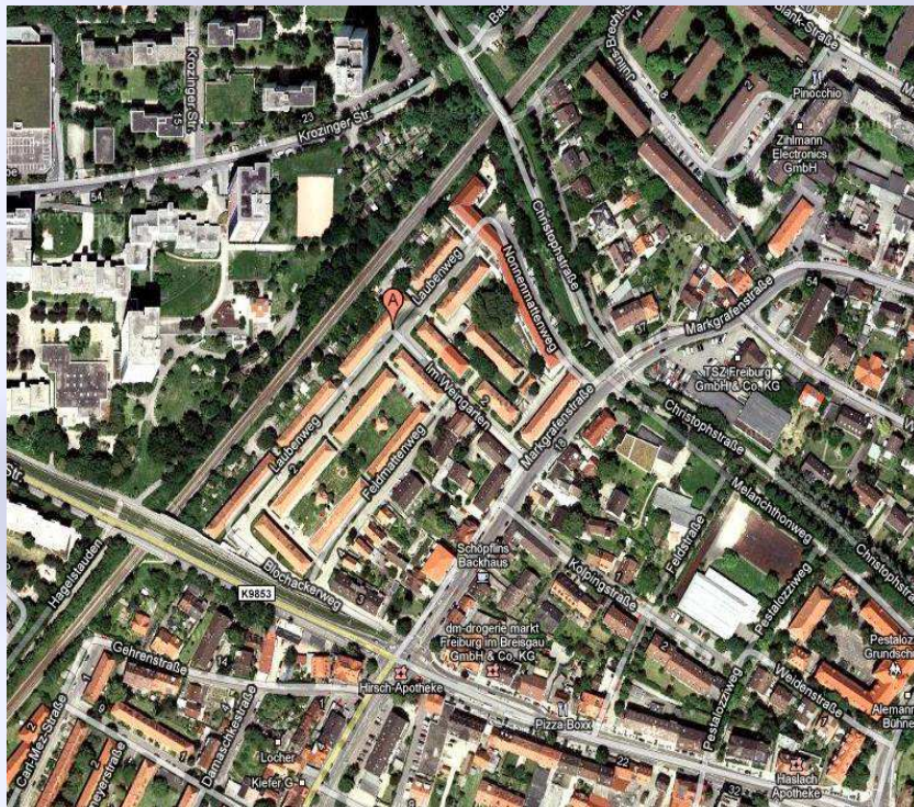
Bebauung vor der Neubaumaßnahme
