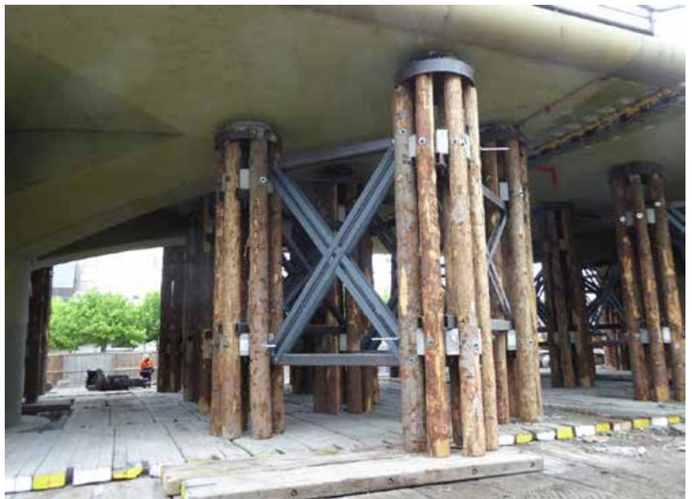
Spezielle Unterkonstruktionen sichern den Abriss
