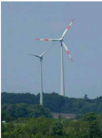
Abb. 12: Windenergieanlagen im Wald.
