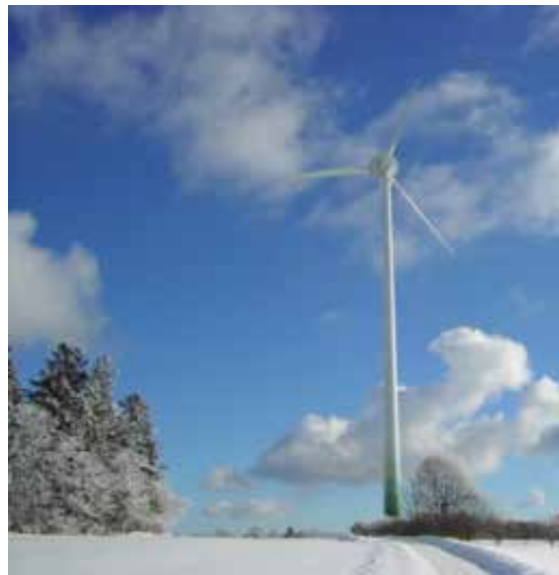
Abb. 9: Windenergieanlage unter Vereisungsbedingungen.
