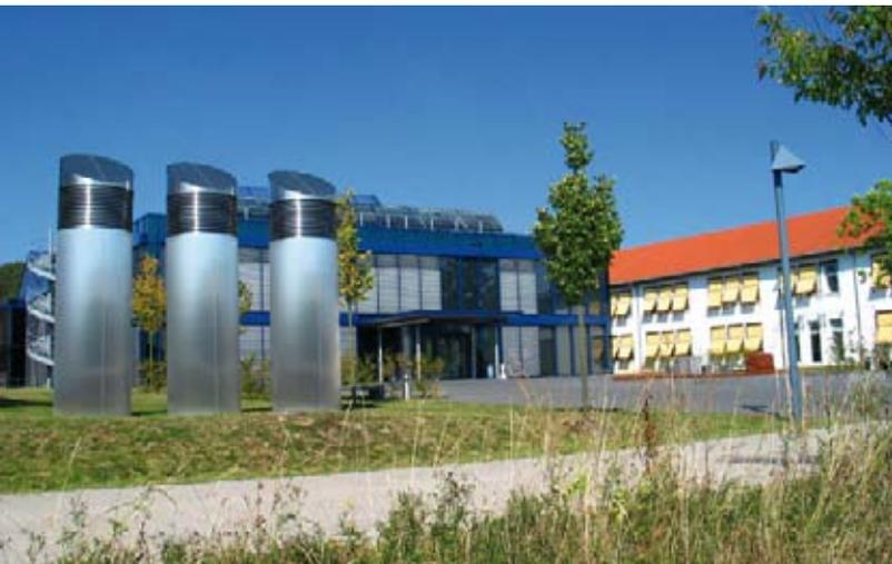
Zentraler Neubau am UCB mit drei Frischluft-Ansaugrohren
