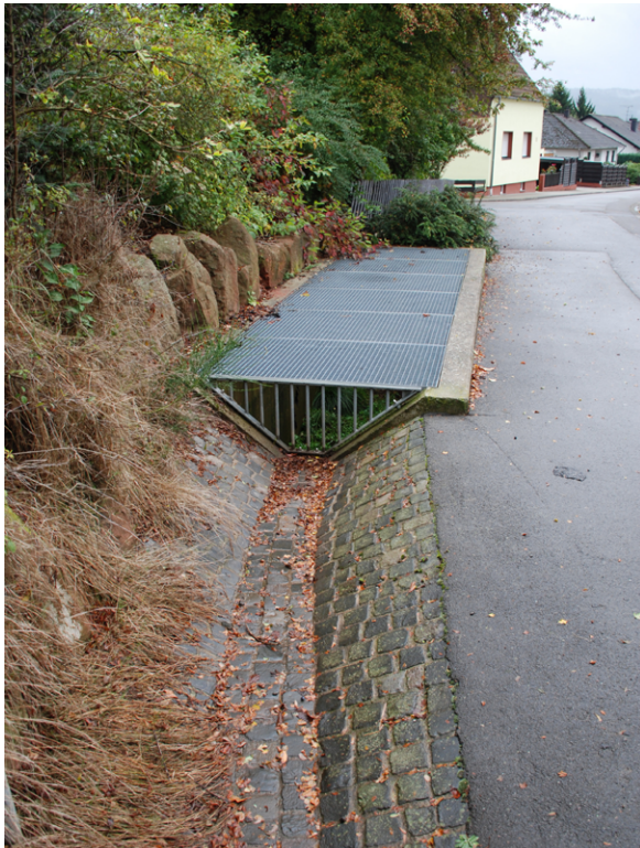
Abb. 7 (links): Einlaufschacht mit Rechen zur Fassung von Oberflächenwasser im Siedlungsbereich.
