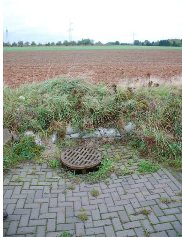
Abb. 7 (links): Einlaufschacht mit Rechen zur Fassung von Oberflächenwasser im Siedlungsbereich.
