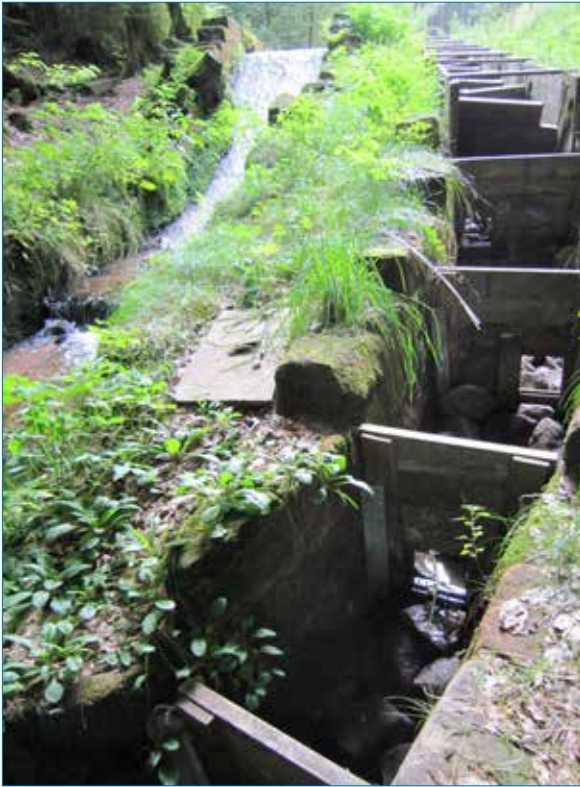
Diese Fischtreppe aus Holz wurde am Modenbach angelegt (Bypass der Kunzenthaler Klause)
