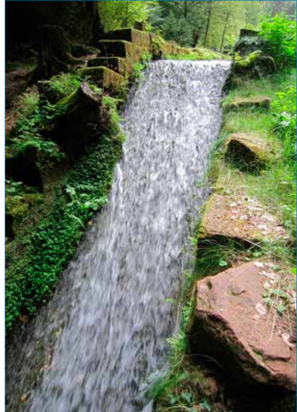
Über diese Rampe, früher als Riesel bezeichnet, sollte das Triftholz starkes Gefälle schadlos überwinden
