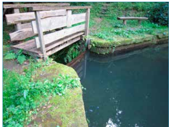
Dieser Triftwoog läuft trichterförmig zu und hat heute noch glatte Uferwände, damit sich das zu triftende Holz nicht verkeilte und schnell weitergeleitet werden konnte
