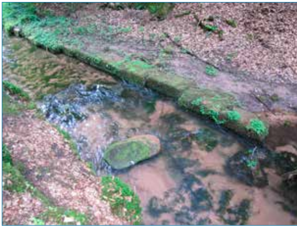
Wo die Bäche größer werden, wurden sie oft für die Holztrift mit Sandsteinen ausgebaut (Kaltenbach)
