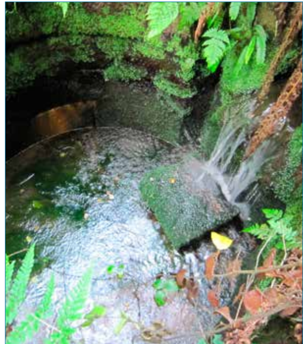
Dies ist kein Brunnen, sondern der Ablauf der Heinrichsklausen. Das runde Becken dürfte eine gleichmäßige Wasserspense garantiert haben
