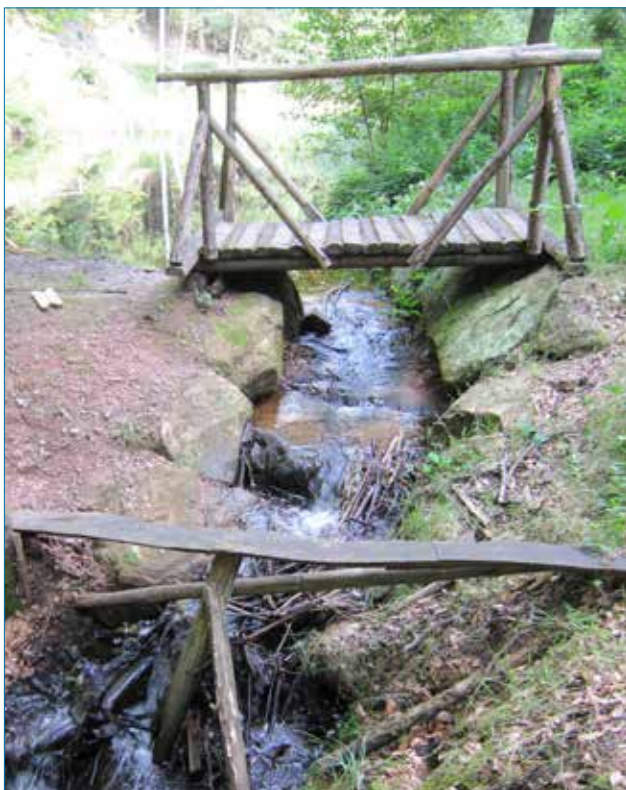
Hier wurde eine Verrohrung am ehemaligen Mönch-Ablauf geöffnet und die Durchgängigkeit verbessert (Haseltal)
