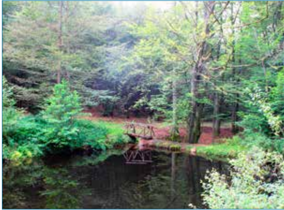
Dämme drohen zu brechen, wenn der Mönch als Ablaufbauwerk verstopft. Dieser Damm wurde saniert, der Mönch durch einen offenen Überlauf mit Steg ersetzt
