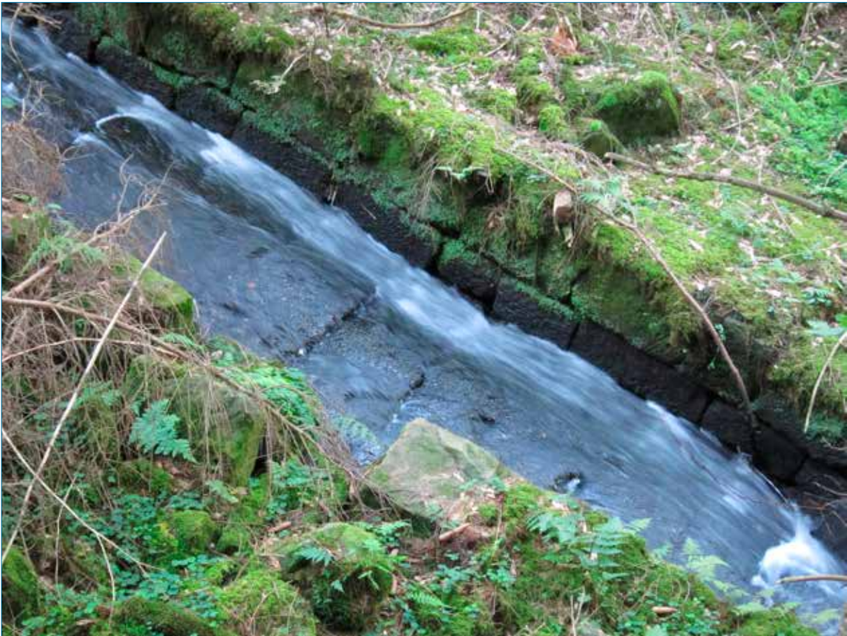
Kulturhistorische Besonderheiten im Pfälzerwald: oben Original-Mönch (regulierbares Ablaufbauwerk) an Triftwoog, unten Schussrinne (Riesel)
