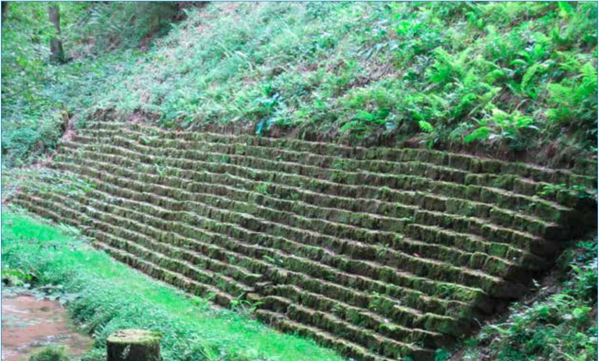
Die Wiederherstellung und Pflege historischer Bausubstanz wie bei dieser Stützmauer zum Einwerfen des Triftholzes ist bedeutsam für den Denkmalschutz (Kaltenbach)
