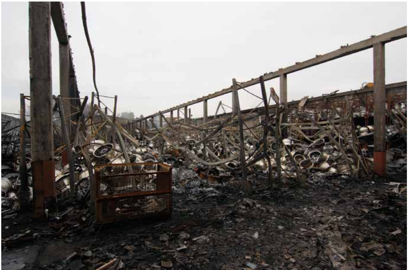
Großbrand einer Gewerbemüllsortieranlage
