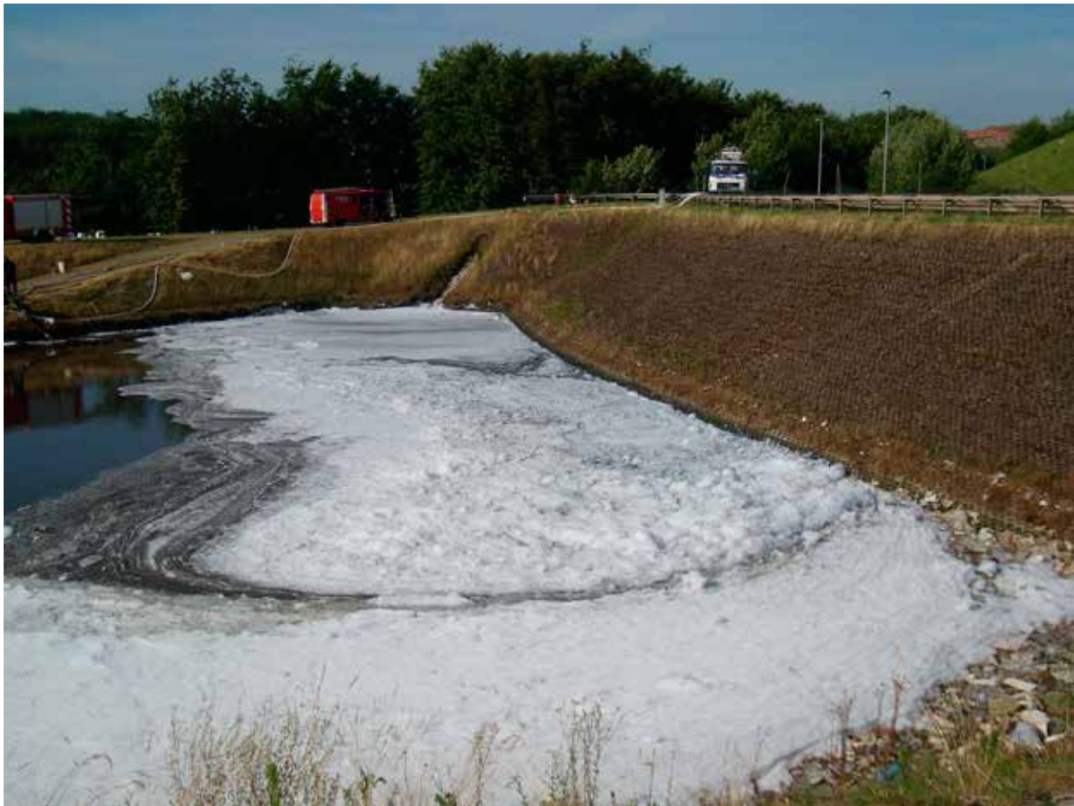
Löschschaum in einem Regenrückhaltebecken
