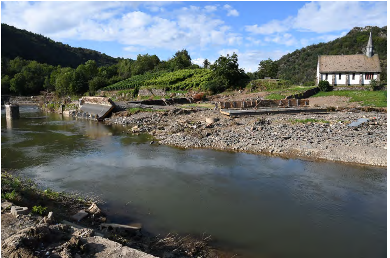
Durch die Flut zerstörte Brücke im Ortsteil Altenahr-Altenburg
