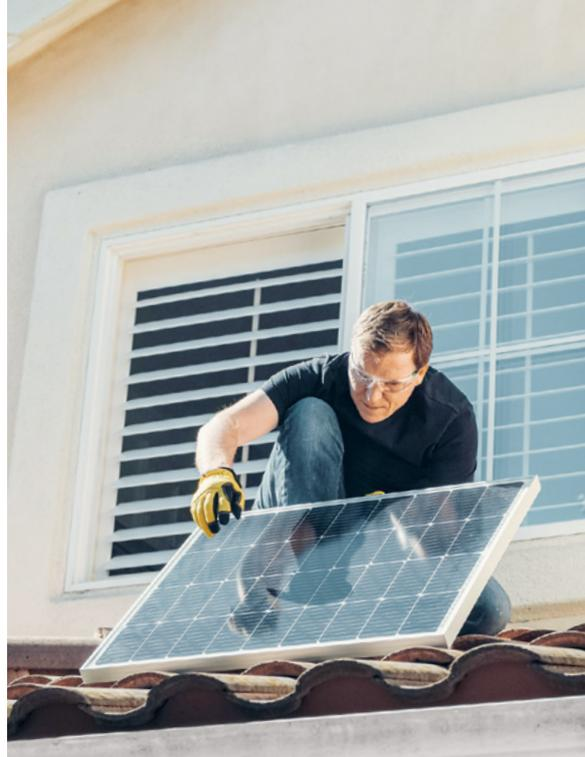
Haushaltsbatteriespeicher werden heute überwiegend in Kombination mit einer PV-Aufdachanlage installiert. Ihre Nutzung erfolgt überwiegend „eigenbedarfsoptimiert“, d. h. der Speicher dient dazu, den eigenen Strombedarf maximal durch die PV-Eigenerzeugung zu decken.
